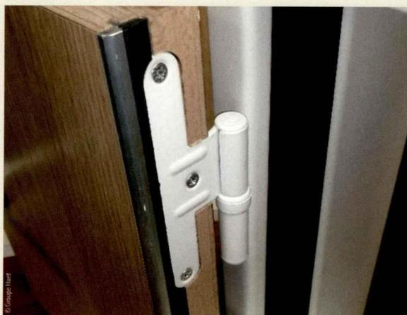
Huisserie PYRO - Mode de pose simplifié sans aucun remplissage et option protection des chants de porte EI30 avec des cornières aluminium
