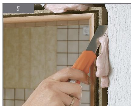
Après séchage, enlevez l'excédent de mousse proprement avec un couteau.
