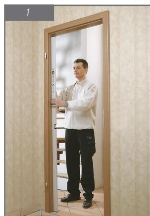
Le chambranle doit maintenant être mis d'aplomb. Utilisez un niveau à bulle et vérifiez à l'intérieur et à l'extérieur.
