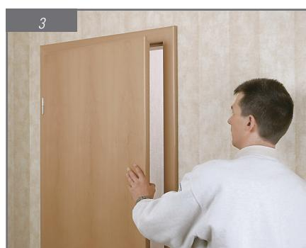
Puis montez provisoirement la porte pour vérifier de la bonne ouverture et fermeture du vantail.
