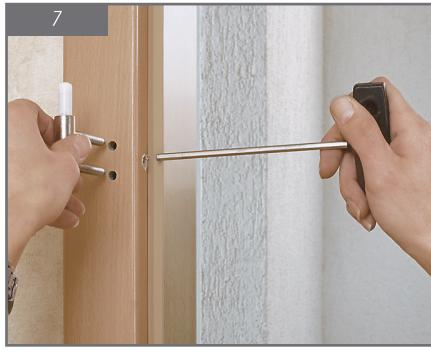
Une fois le chambranle assemblé, redressez le et insérez les fiches dans les trous prévus. Les fiches peuvent être fixées de l'intérieur.
