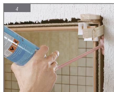
Réglez si nécessaire les barres d'écartement. Lorsque l'ensemble est ajusté, remplissez les espaces entre le chambranle et la cloison de mousse polyuréthane bi-composant.
