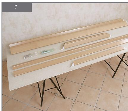
L'assemblage du chambranle se fait idéalement sur une grande table ou, comme ici, sur deux tréteaux sur lesquels a été posée une plaque de bois.
