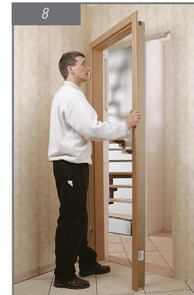
Positionnez le chambranle dans l'ouverture du mur. Il doit s'intégrer parfaitement.
