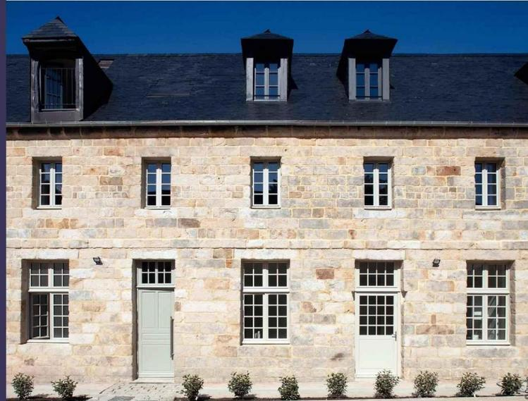
Deux modèles de portes d'entrée sur mesure Ouvêo dotés de petits bois collés directement sur le vitrage, posés dans Le couvent des Pénitents
